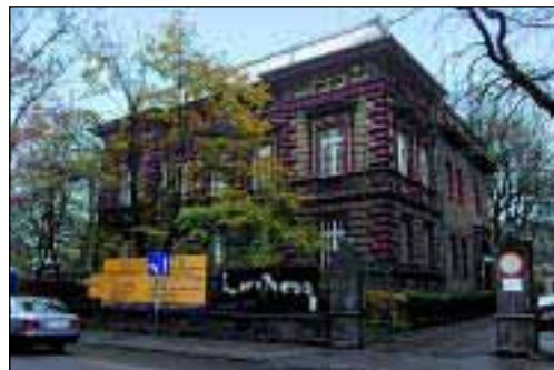
Siedziba Małopolskiej Okręgowej Izby Inżynierów Budownictwa przy ul. Warszawskiej w Krakowie
